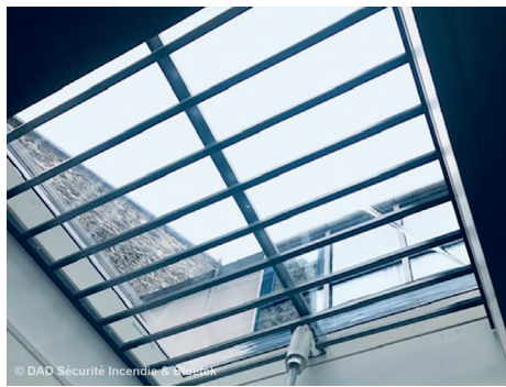
Dispositif Bluetek de lanterneau Bluecoif Therm Air de la Ligue de l'Enseignement à Paris
