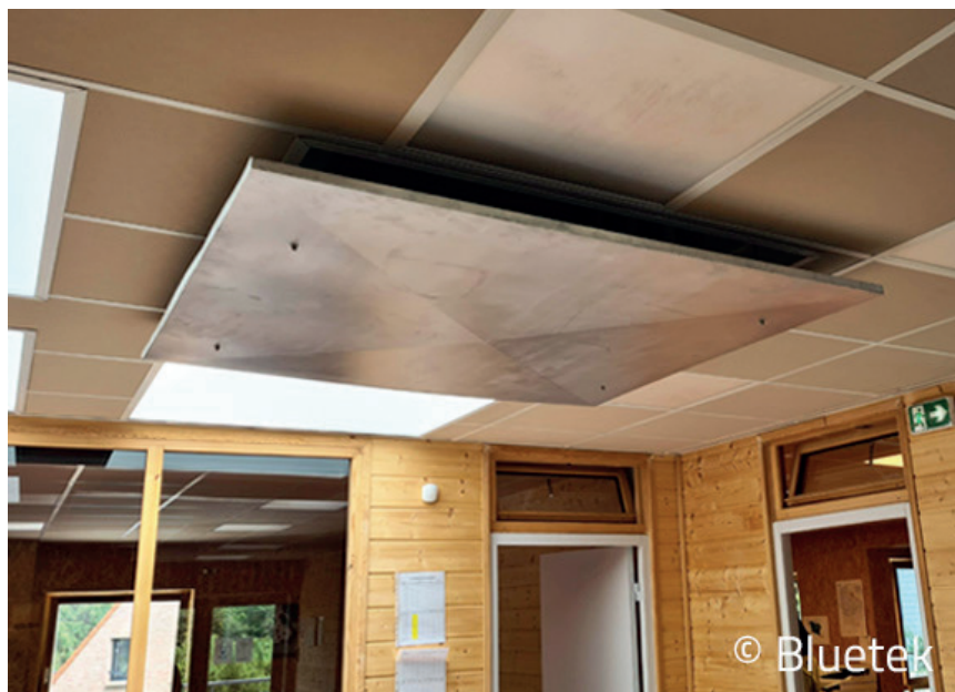
Finition Rafraîchissement d’Air par Evaporation - Ferme du Sens – octobre 2021
